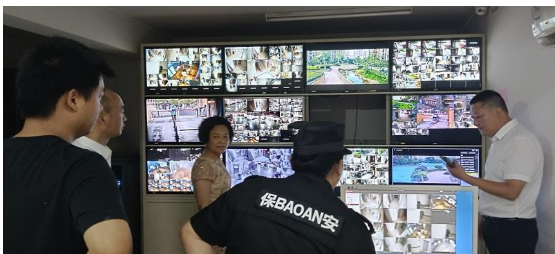
专家检查消防控制室证书和 30 天内的监控录像储存情况
